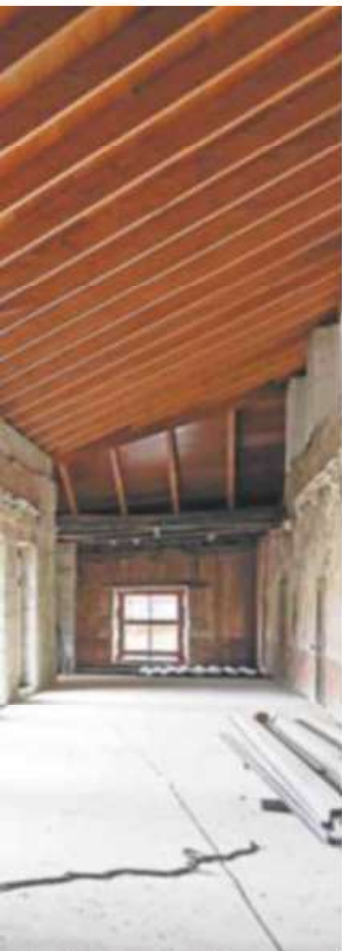
Los alrededores del claustro alto del monasterio de San Juan de los Ríos dejan ver ya su auténtica dimensión, con el uso de madera y elementos como las ménsulas que sostienen el antiguo techo interno o las ya renovadas vigas, de la máxima calidad. FOTOS: PABLO NOSTI
